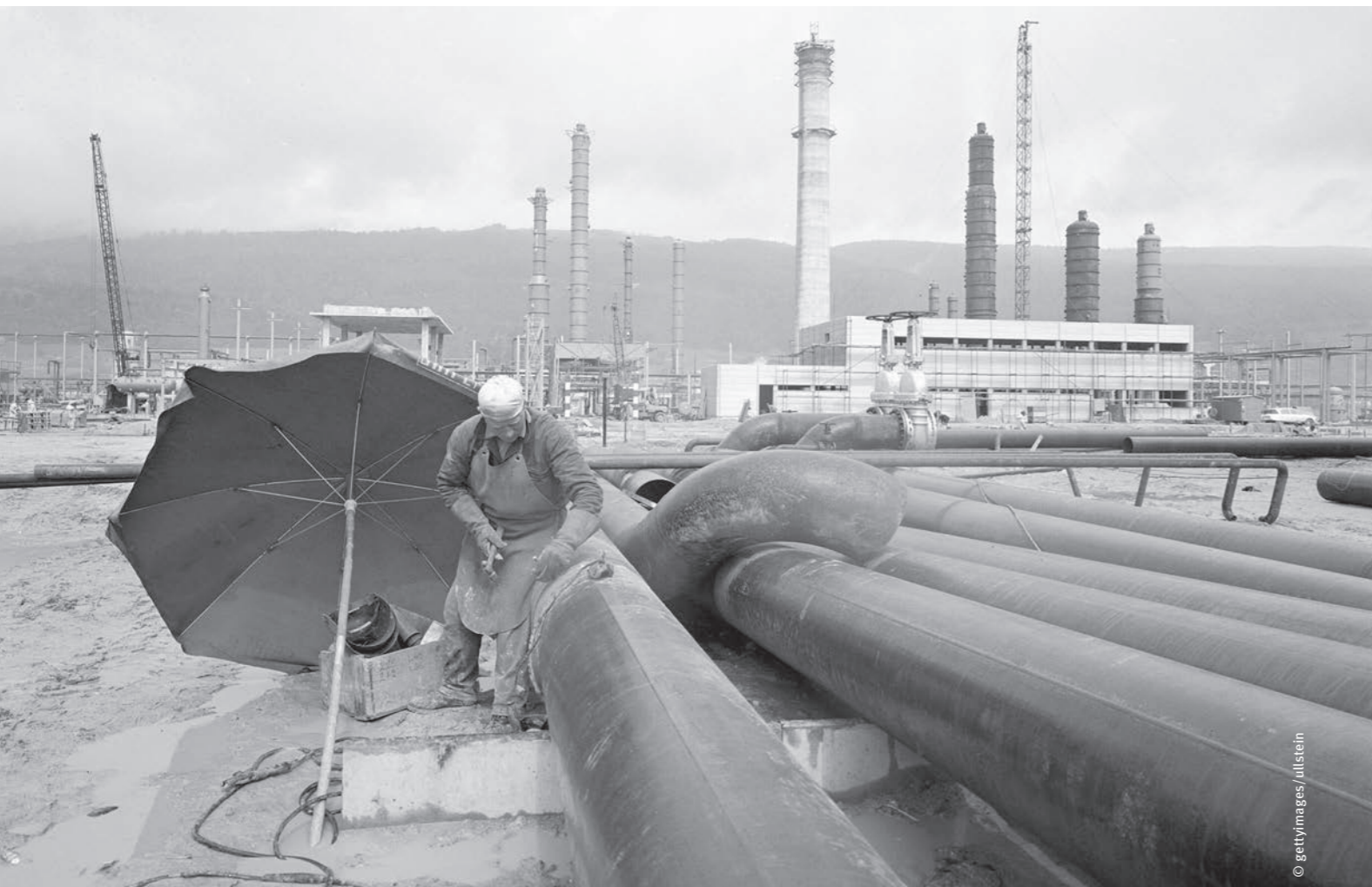
Bau der Inlandraffinerie in Cressier.
